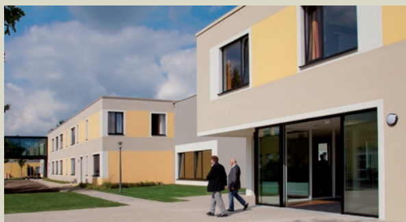
Ansicht des Haupteinganges der Geriatrie. Das Gebäude der Orthopädie im Hintergrund.
